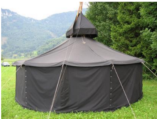
Abbildung 2 Jurte, Durchmesser ~10 m bis 12 m mit Abspannung
